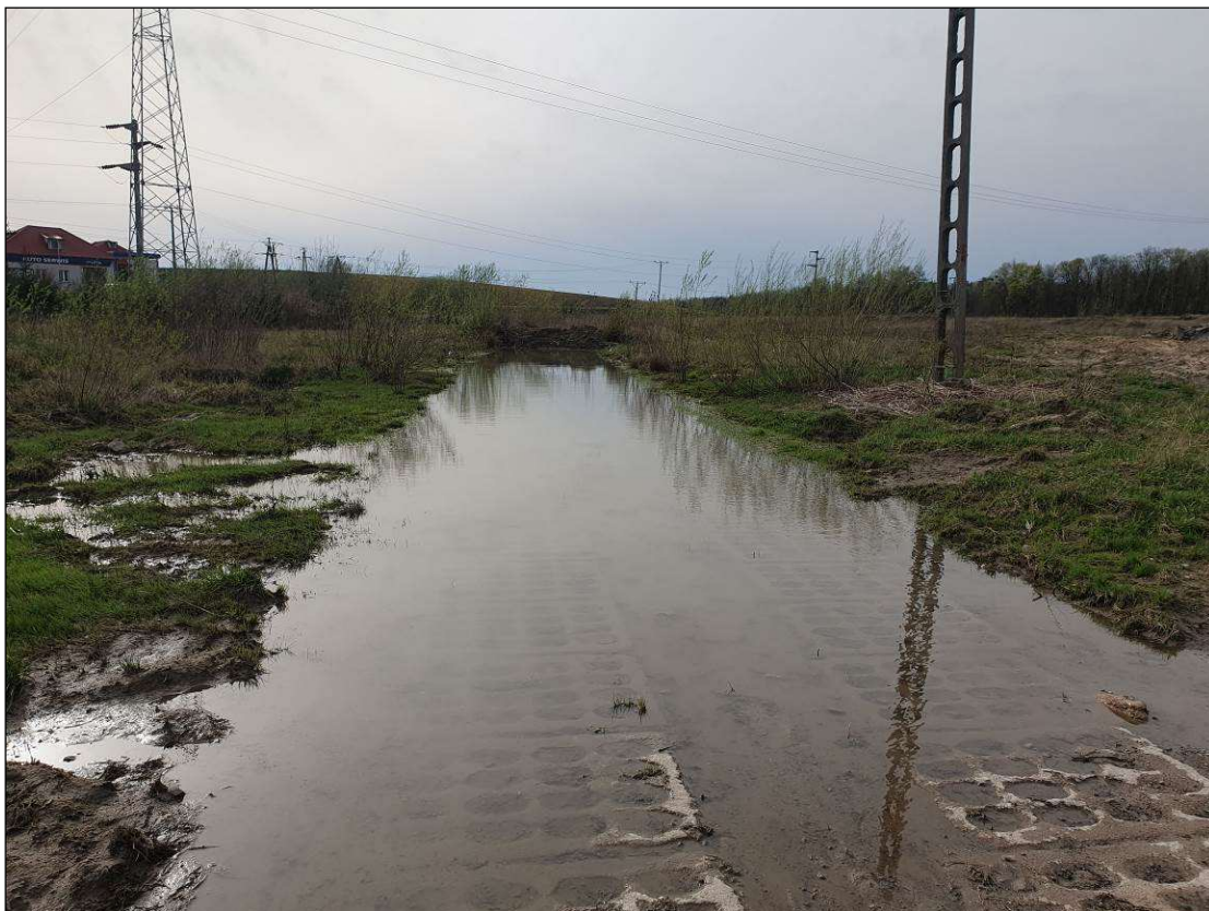
Fot. 3 Teren prowadzonych prac budowlanych w obrębie projektowanego obszaru 3U i 1KDL (fot. własna)
